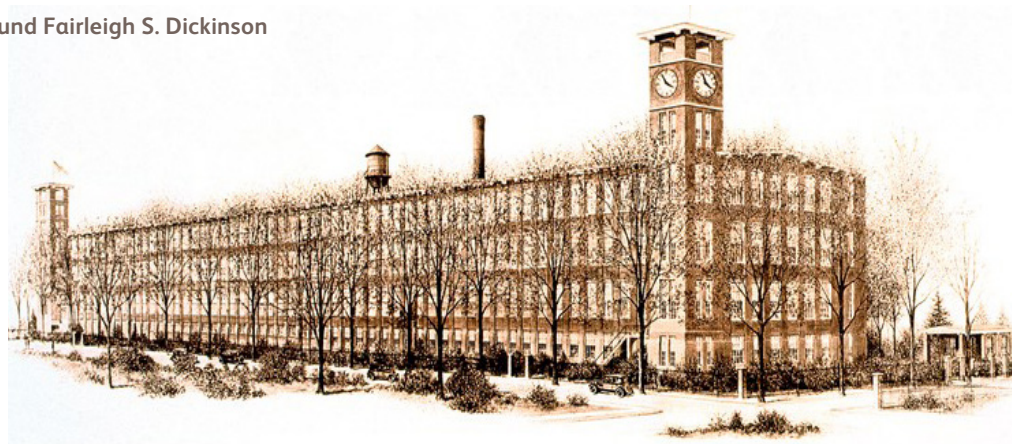
East Rutherford, New Jersey (1906). Erstes Werk und Hauptsitz des Unternehmens.
